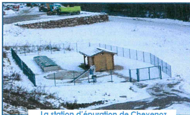
La station d'épuration de Chevenoz
